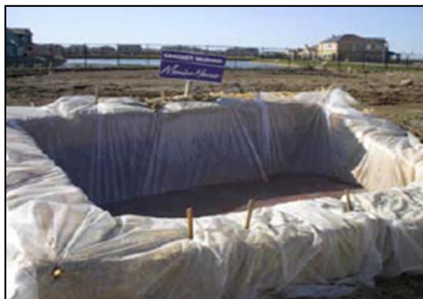
شکل ۳- تصویر یک مکان آماده شده در کارگاه جهت شستشوی ضایعات بتن
