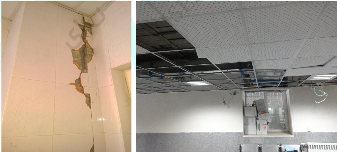
شکل ۱۵-۵- آسیب‌های وارده به سقف‌های کاذب و دیوارهای مرکز بهداشت و درمان دالاهو در شهر کرد
